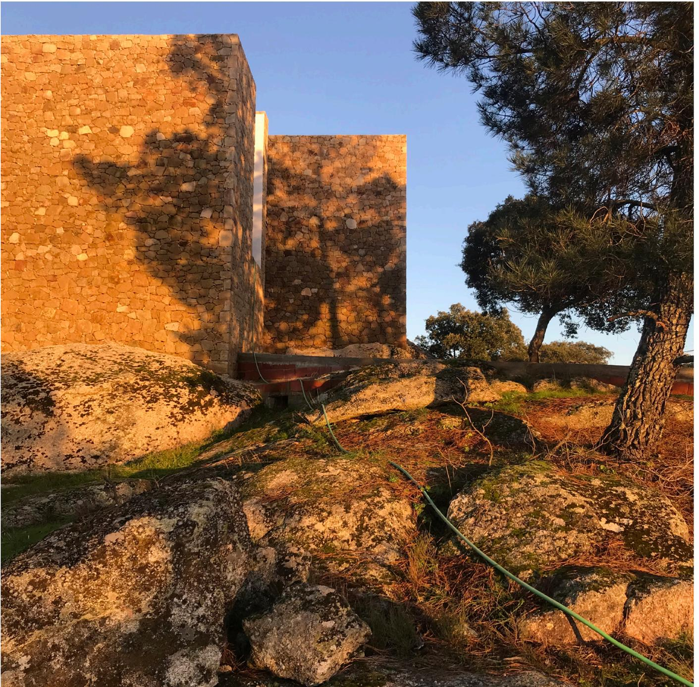
8. - Il n'y pas de linteau : pour chaque ouverture, les murs s'interrompent jusqu'en haut, laissant apparaître la dalle du plancher, comme s'il s'agissait d'une ruine.
