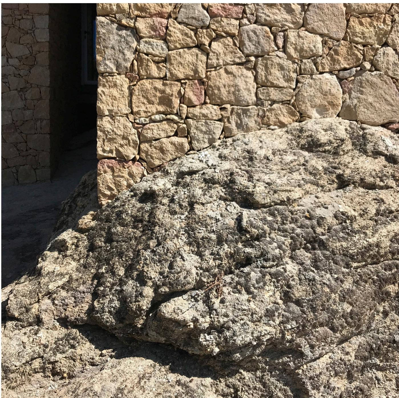
10. - Des fers insérés dans les murs et accrochés à la structure ont permis d'utiliser un mortier à la chaux, laissant imaginer, comme le suggère l'architecte Gilles Perraudin, que les vestiges de la construction pourront servir de carrières à de nouveaux bâtisseurs.
