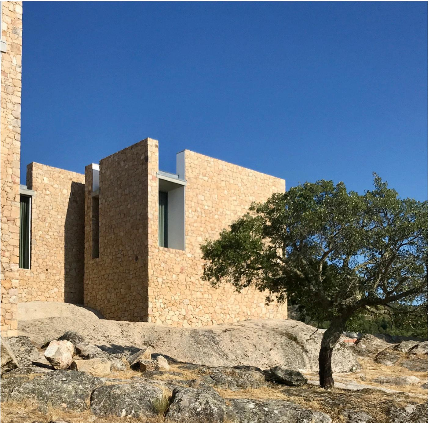
9. - Les moellons proviennent de blocs de granit récupérés dans une carrière située à trois kilomètres du site. Ces blocs sont fendus à la masse, sans sciage mécanique, de manière à préserver l'aspect brut de la surface, puis assemblés à la manière d'un puzzle savant. Des petites pierres prélevées sur le terrain sont ensuite introduites dans les joints.
