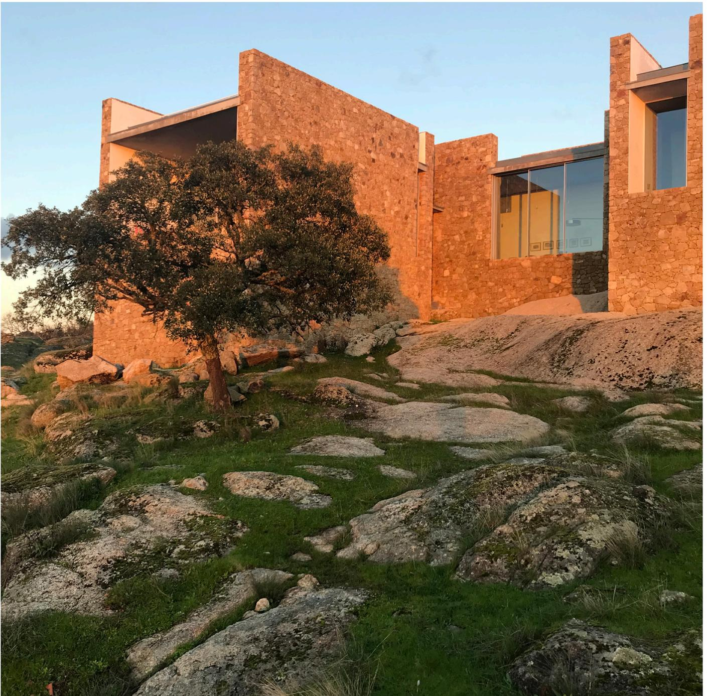
7. - L'archaïsme peut s'exprimer de deux façons distinctes : par la présence d'une ossature ou par la primauté d'une clôture primordiale (Kenneth Frampton). C'est cette seconde façon qui a été privilégiée : les poteaux supportant les dalles en béton du rez-de-chaussée et de la toiture sont noyés dans l'épaisseur des murs en pierre.
